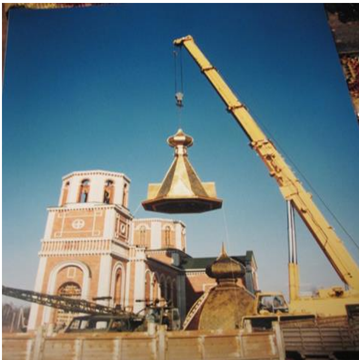
Будівництво храму Архистратига Михаїла
