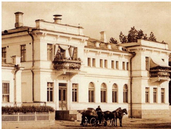
Будівля в с.Тростянець Охтирського повіту в якій знаходилась Економічна бібліотека
